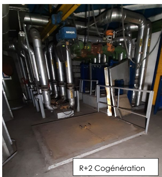
Figure 28 : Aperçu d'ouvertures à combler et sécuriser à la suite du démantèlement
