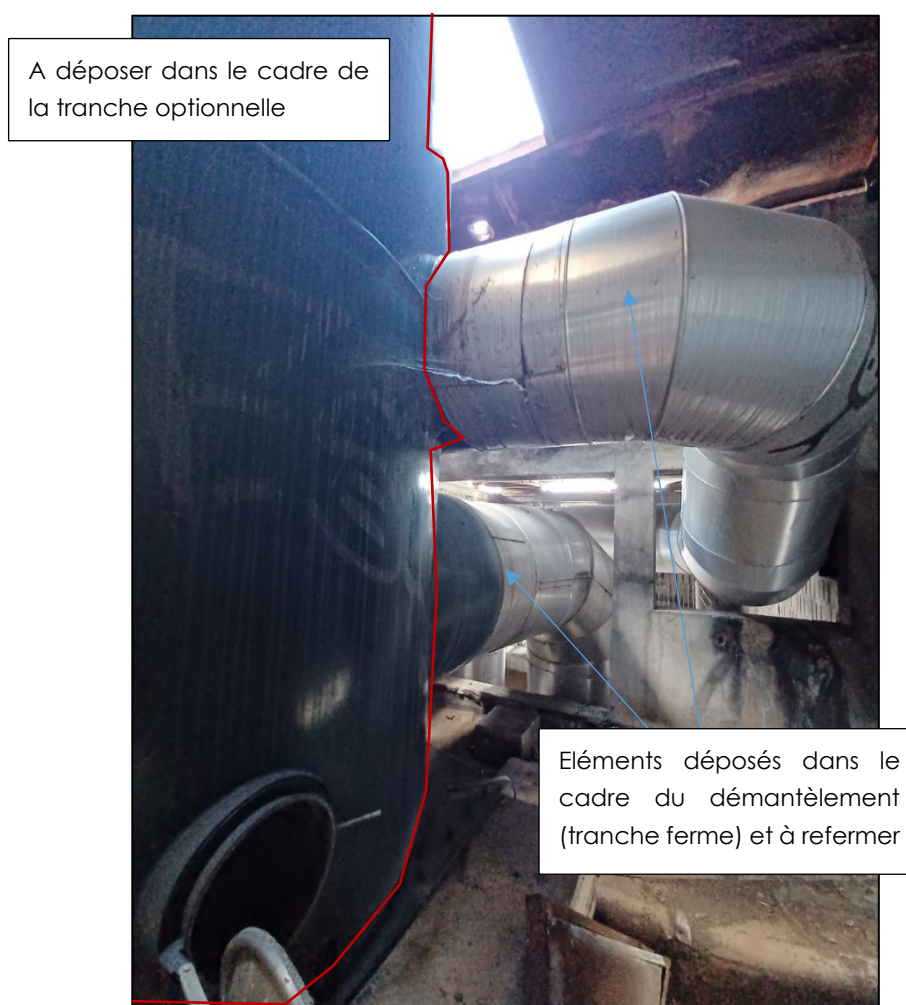
Figure 15 : Aperçu de la cheminée gaz à déposer
