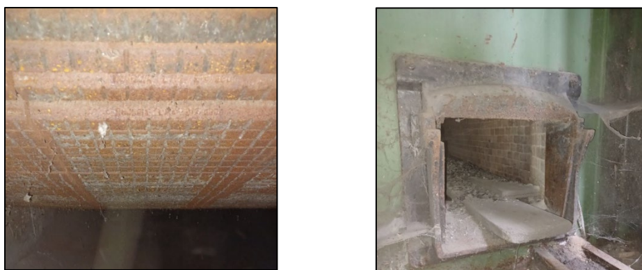
Figure 8 - Aperçu des briques présentes dans les chaudières charbon, visibles par les trappes d'accès
