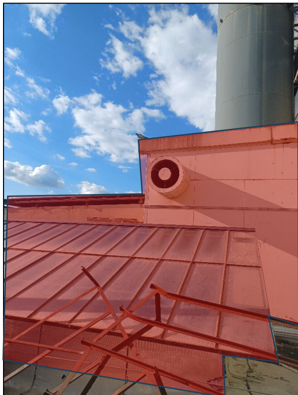
Figure 17 : Purge des toitures et structures au pied de la cheminée
