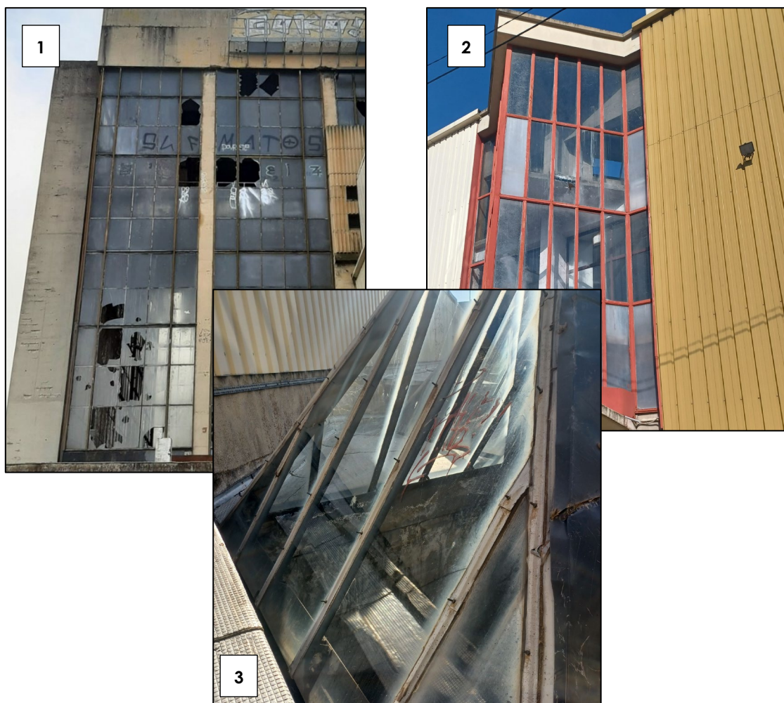
Figure 14 : Verrières contenant de l'amiante concernées par le maintien en place des châssis vitrés
