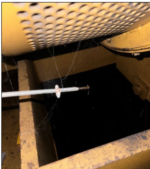
Figure 7 - Présence d'huile dans les rétentions sous les unités de cogénération
