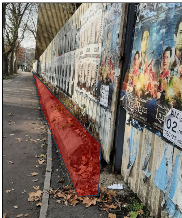
Figure 10 : Démolition du muret en partie basse du barriérage Est et repose d'un bac acier
