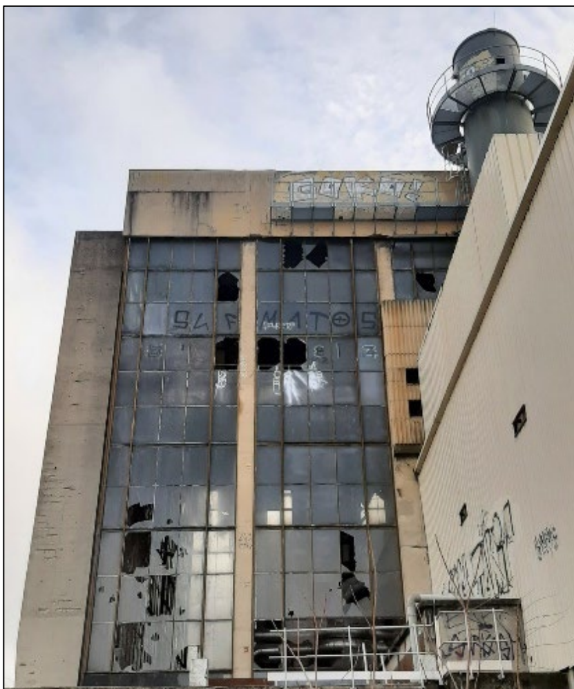
Figure 3 - Aperçu des verrières contenant des joints de vitrages amiantés
